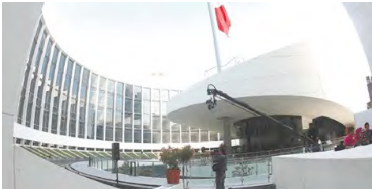
La nueva sede de la Cámara de Senadores fue inaugurada en 2010. Al igual que la sede anterior, ésta se localiza en la Ciudad de México. Cuenta con 16 pisos para las comisiones, oficinas, salas de usos múltiples, área de servicios técnicos y parlamentarios.
